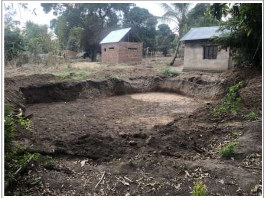
Der Bau des ersten Teichs in Mpanga.
