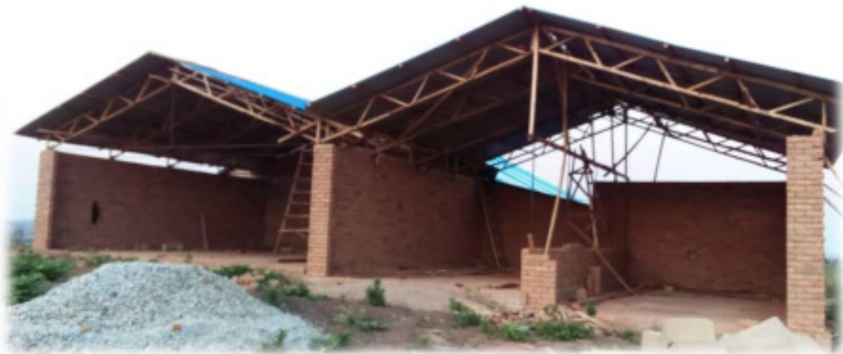
Die neue Schule nimmt Gestalt an.
