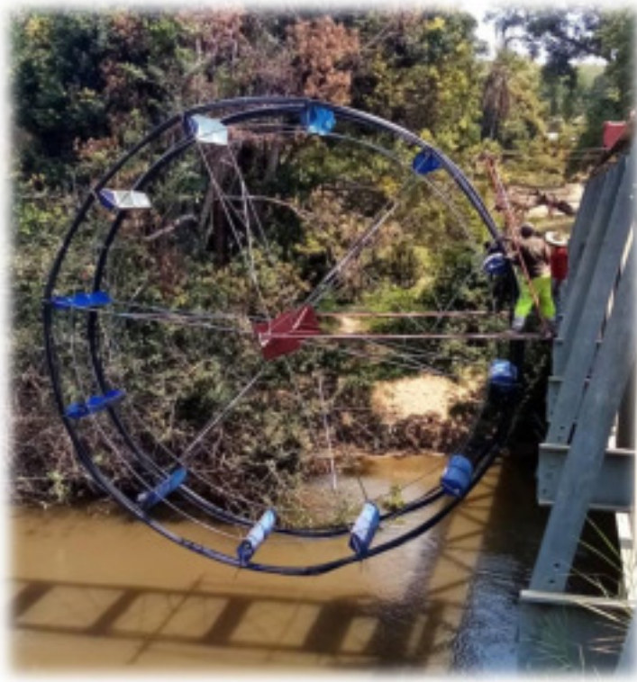
Die Wasserversorgung von Mpanga.
